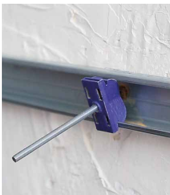
Mise en place
